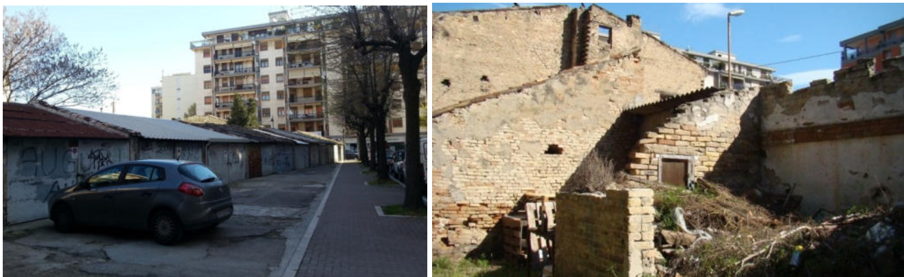
Fig 7 e 8: foto baracche ed edifici in via Lazio e in via Marche da demolire
