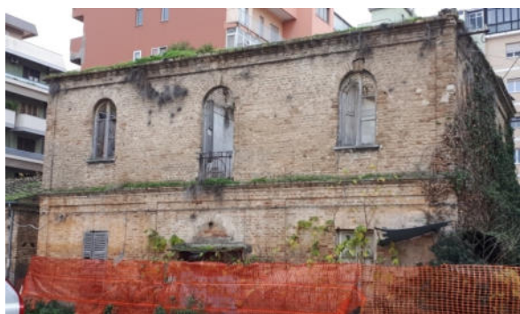
Fig 3: ex casa Armatore da recuperare a destinazione pubblica
