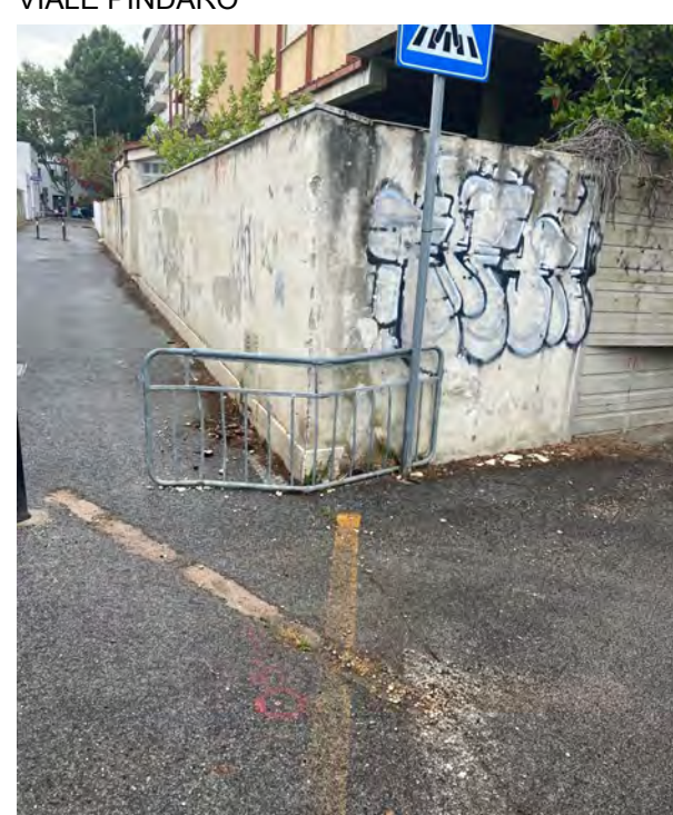
POSIZIONE CHODIO N.5000 VIA A. POLLIONE
