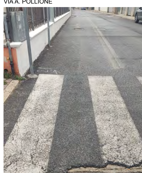
POSIZIONE CHODIO N.6000 VIALE MARCONI ANGOLO VIA A. POLLIONE
